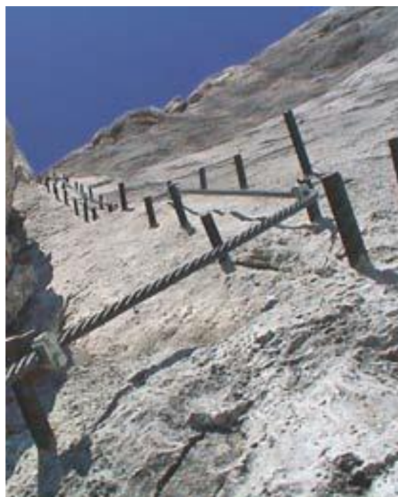
Slika 52: stopni klini predstavljajo povečano nevarnost poškodb
