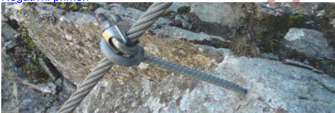
Slik 36: Uporaba neatestiranih očesnih matic brez prečne nosilnosti; Glede na premer sidra je njegova zunanja dolžina opazno prevelika, obstaja velika verjetnost utrujanja materiala; neprimerna uporaba spojke za jekleno vrv.
