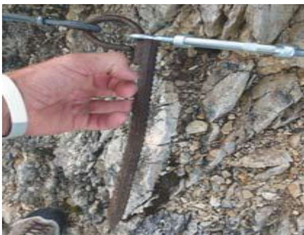
Slika 43: Krpanje v sistemu varoval je lahko nevarno
