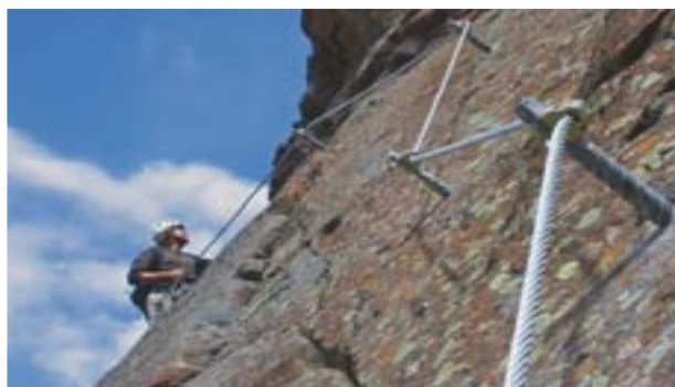
Slika 35: dobro stanje sider, poravnana – blago napeta jeklena vrv, dober izbor smeri poti, uporaba naravnih stop in oprimkov
