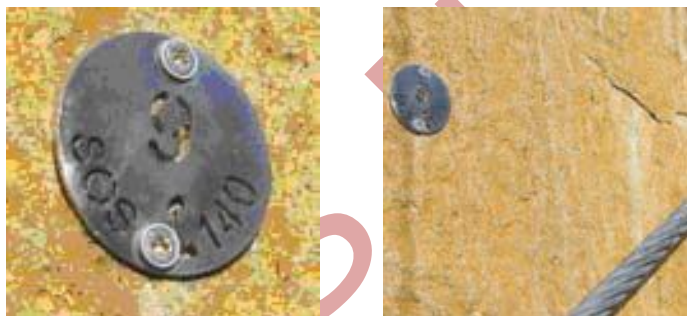
Slika 55: Primer oštevilčevanja nekega odseka zavarovane plezalne poti
