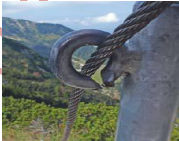
Slika 44: sistem sidranja z očesnimi sidri in preslabo napeta jeklena vrv, ki je nevarno poškodovala oko sidra
