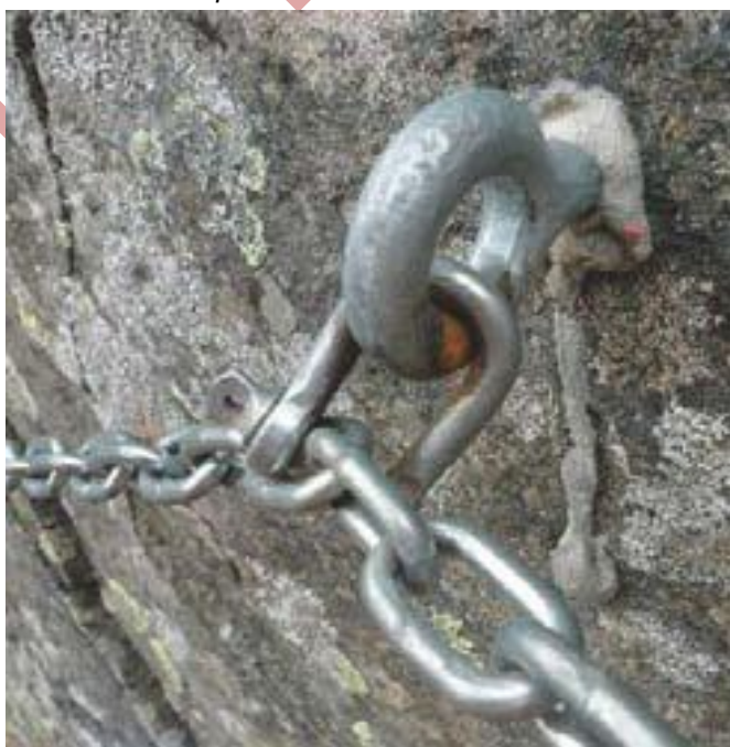
Slika 54: vsaka veriga je tako močna kot je njen najšibkejši člen; ta način varovanja (namesto jeklene vrvi) ni optimalen (še sprejemljiv), vendar naj ne bo v nobenem primeru uporabljen v zavarovanih plezalnih poteh! Vijačni sistem naj bo vedno fiksiran!
