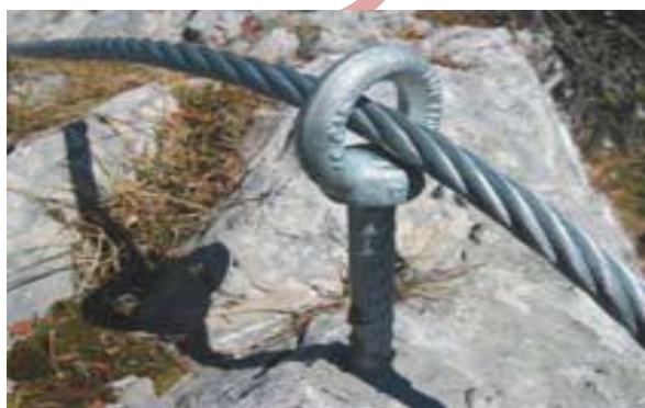
Slika 49: Obročne matice nimajo prečne nosilnosti
