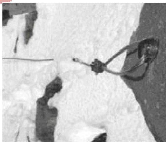
Slika 39: 1, 2, 3 – o zadostni nosilnosti sidra tukaj ne moremo govoriti !
