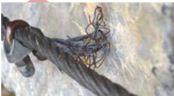
Slika 45: razcefrana jeklena vrv predstavlja nevarnost poškodb za plezalca
