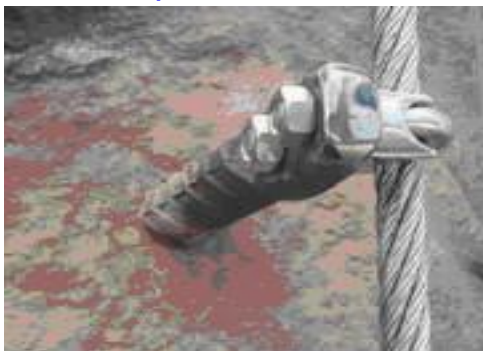
Slika 34: masivno, ploščato-kovano sidro namenjeno prečnim obremenitvam
