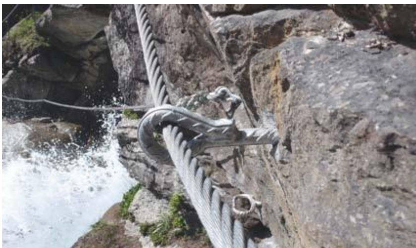
Slika 30: Vmesno očesno sidro iz prednapetega jekla z močno prednapeto jekleno vrvjo (notranja stran očesa je gladka in brez robov)
