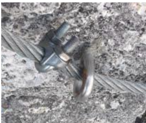
Slika 38: spojka jeklene vrvi pred in po očesu vmesnega sidra ni pripročljiva
