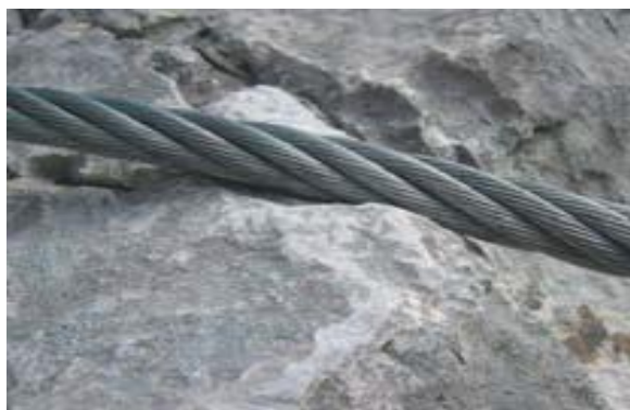
Slika 50: jeklena vrv se drgne ob skalo in se kmalu poškoduje.
