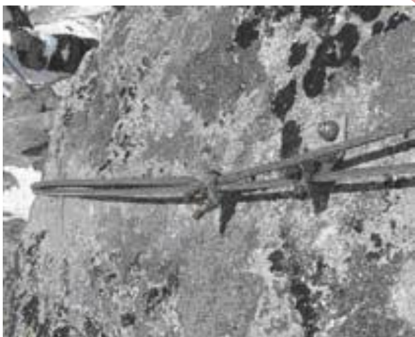
Slika 39: 1, 2, 3 – o zadostni nosilnosti sidra tukaj ne moremo govoriti !
